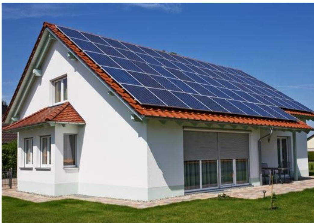
Un impianto fotovoltaico standard è formato da moduli in silicio che riescono a trasformare l'energia solare in energia elettrica, attraverso un inverter, apparecchio in grado di convertire l'energia elettrica prodotta dai pannelli fotovoltaici da continua in alternata. L'energia così prodotta può essere utilizzata per gli utilizzi domestici o immessa in rete. Si rimanda al documento "Fotovoltaico 2014" per un maggior dettaglio.
